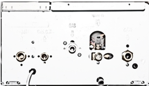
рис. 6 – Кран заполнения котла
